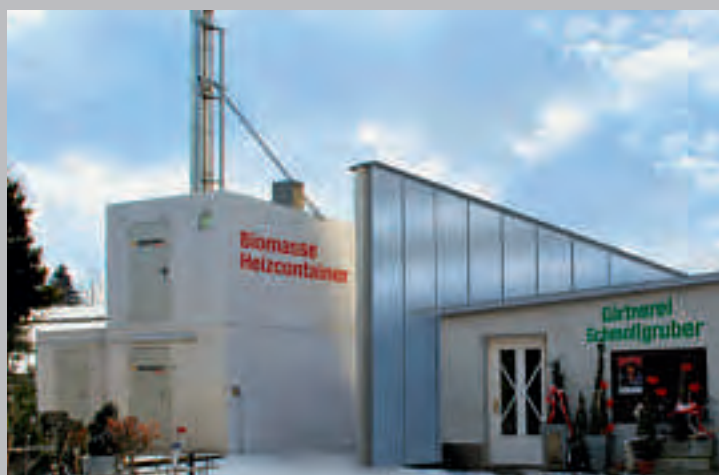
Dreifach-Hackgut-Heizcontainer bei einer Gärtnerei.
