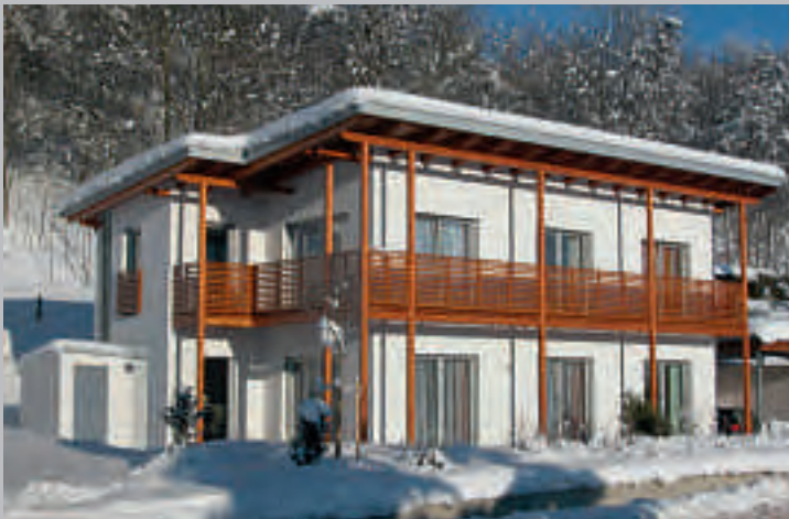
Einstock-Heizcontainer direkt an der Wohnhausanlage.
